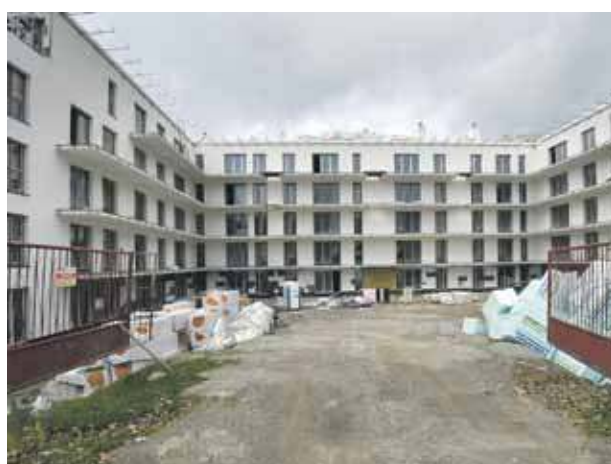
Ponad połowa z 241 apartamentów w powstającym na Szymonach budynku jest już sprzedana.
