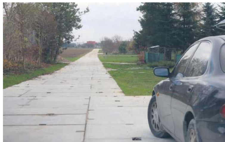
Kiedy na działkach przy ulicy gen. Grota Roweckiego zaczną powstawać „mieszkania plus” nie wiadomo. Na razie miastu udało się wybudować tymczasową drogę dojazdową do przyszłego placu budowy
