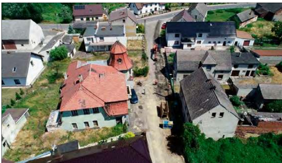
Budowa sieci kanalizacyjnej kosztowała ponad 8 i pół miliona złotych.
