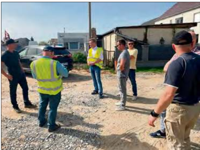
Budowa sieci kanalizacyjnej w Ścigowie zakończona.
