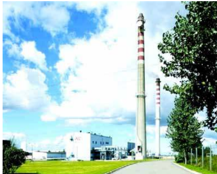
PEC przechodzi na okres letni i do podgrzania wody wykorzystuje wyłącznie odnawialne źródła energii
