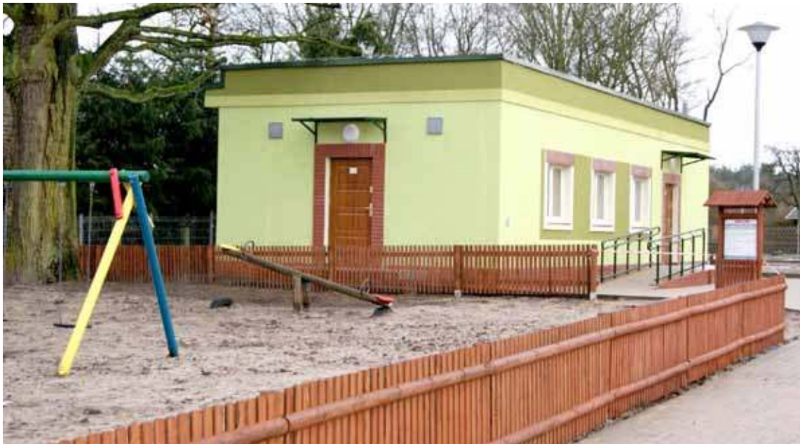
Strażacy skontrolowali 13 świetlic w gminie Stargard, w 7 wykryto nieprawidłowości.
