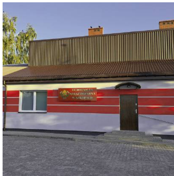
FOT.: GMINA REPKI
