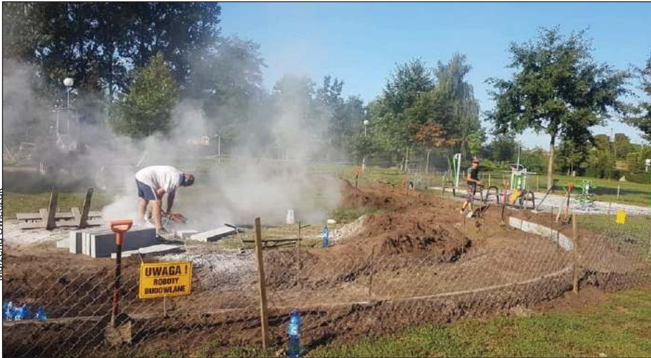
Prace związane z budową placu sportowo- rekreacyjnego na „Zarzeczcu” już się rozpoczęły. Inwestycja ma kosztować 286.000 zł
