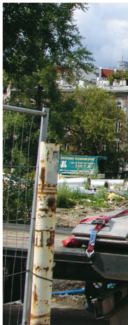
Porządkowanie terenu po wywiezionych kontenerach
