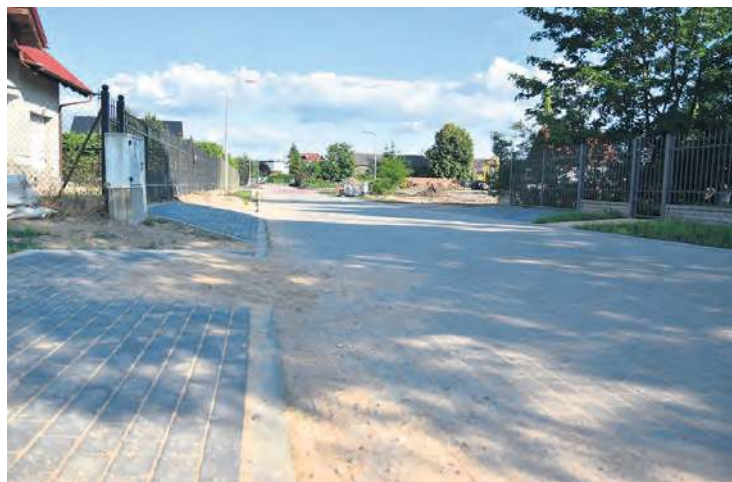
Wejście od strony ul. Akacjowej mają dwie zamieszkałe posesje. Do każdej z nich prowadzą podjazdy o różnym nachyleniu. Przy domu pani Grażyny wykonano na razie jeden wjazd. Na kolejny, do garażu, o jeszcze większym nachyleniu i schody mieszkanka się nie zgadza.
