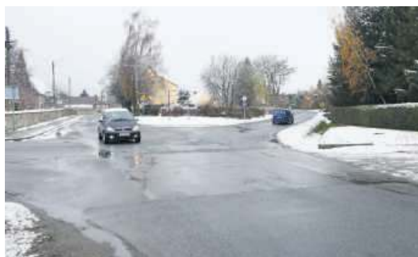
W ramach środków z Polskiego Ładu planowana jest przebudowa drogi powiatowej od skrzyżowania ulic: Szkolnej, Strzebińskiej i Okrężnej
