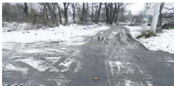
Tak wygląda wjazd w przyszłą drogę z ul. Mieszka I
