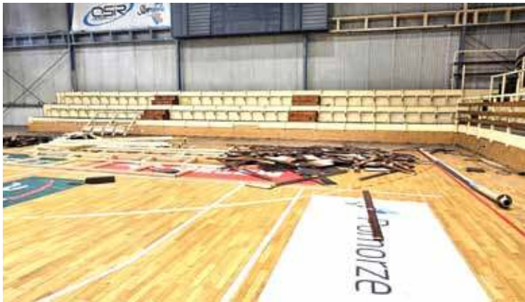
Będzie nowy parkiet, który zostanie wykonany z paneli o grubości ponad 2 cm
