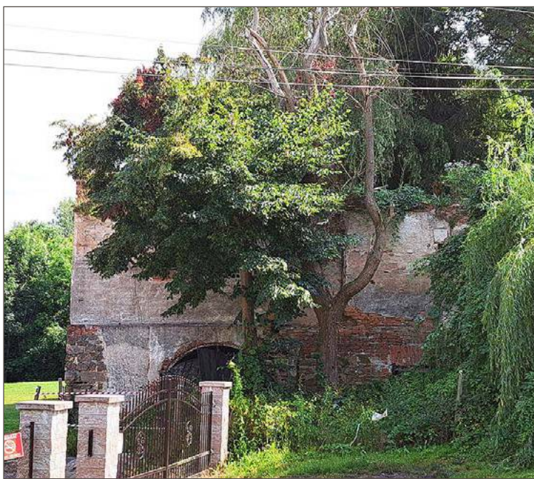
Na remont zabytkowej budowli naciska od dawna Wojewódzki Konserwator Zabytków w Przemyślu.
