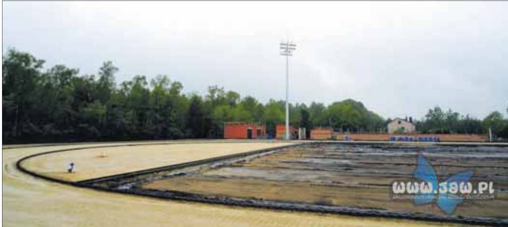
Budowa stadionu lekkoatletycznego w Jaworznie
