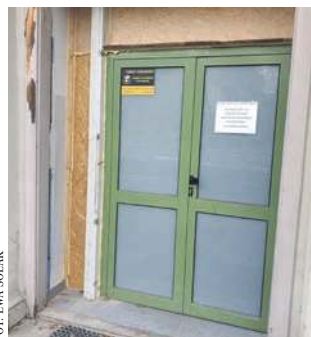
Tymczasowe drzwi zamontowane do czasu renowacji zabytkowych
