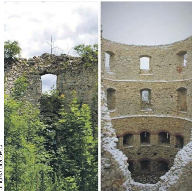
Widok na fragment zamku przed i po zakończeniu tegorocznych robót zabezpieczających
