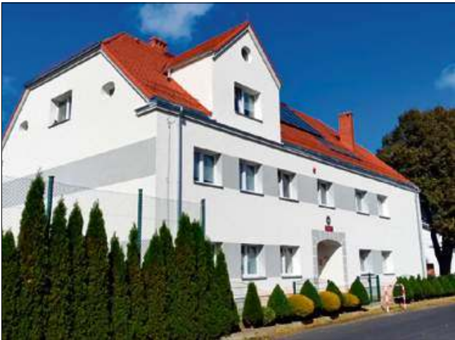
Tak prezentuje się budynek po remoncie.
