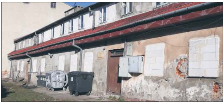
Kamienica przy ul. Królewieckiej 18 – widok od strony ulicy Tumskiej
