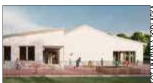
Przy przebudowanym budynku znajdzie się miejsce na plac zabaw
