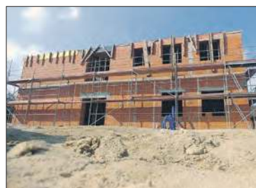
Tak prezentował się obiekt podczas prac na koniec września.
