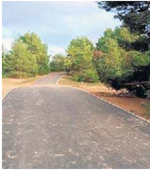
Kolejny odcinek Wielkiej Pętli Fordonu zyskał asfalt
