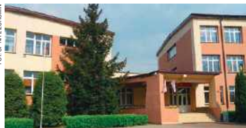
Burmistrz poinformował, że żłobek będzie się mieścił w starej kotłowni Szkoły Podstawowej nr 2 w Żurominie.
