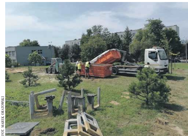
Prace rozpoczęły się w ubiegłym tygodniu
