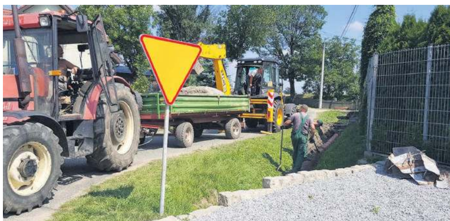
Pracownicy Powiatowego Zarządu Dróg w Strzelinie podczas budowy chodnika w Czerwieńcu (Foto: Sołectwo Czerwieniec)
