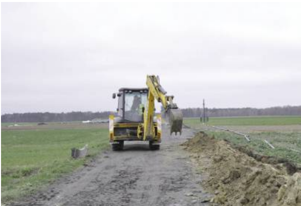
Prace remontowe na gminnych drogach
