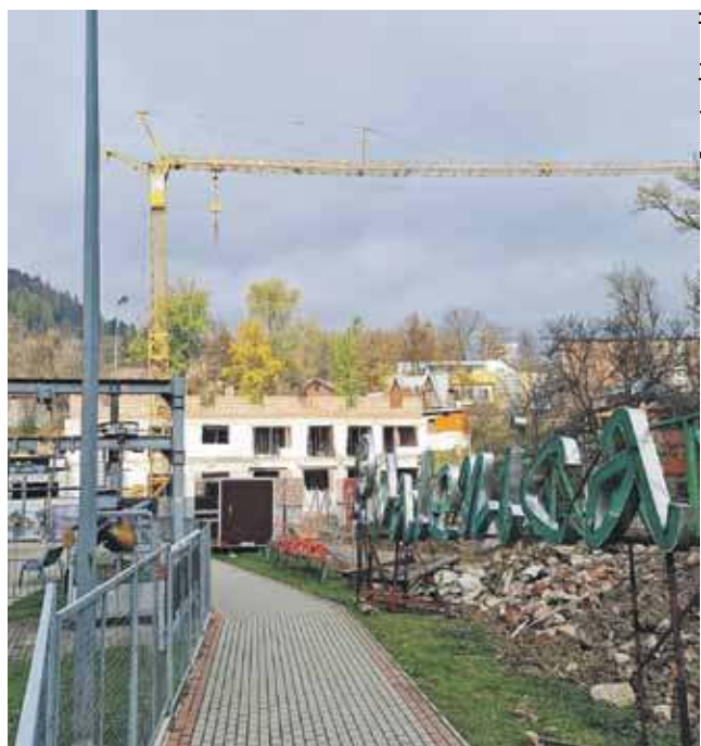
Trwa przebudowa restauracji i hotelu przy dolnej stacji kolei krzesełkowej PKL Palenica w Szczawnicy.
