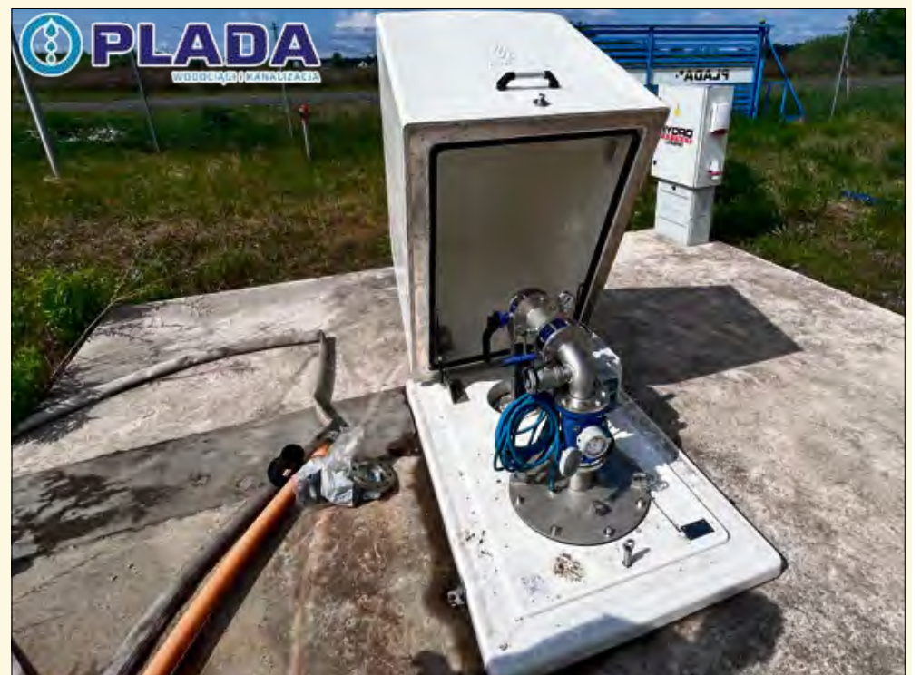
Studnia głębinowa już została wybudowana.
