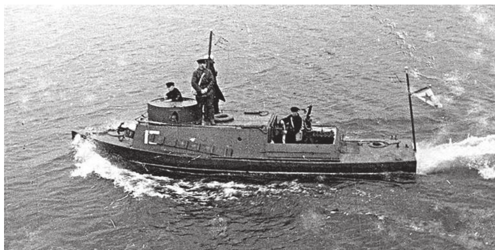
Biorący udział w desancie na Serock kuter „Maluch” – tzw. Typ „D”. Cztery jednostki tego typu zostały wybudowane w okresie I Wojny Światowej. Zatopione w 1941 r. W 1944 r. podniesione z dna Prypeci i po generalnym remoncie włączone w skład Floty Dnieprzańskiej. Fot. z lat 30 XX w.
