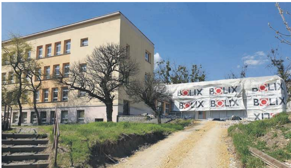
Modernizowany budynek przy ul. Borelowskiego w Chrzanowie, gdzie ma być przeniesiona szkoła muzyczna
