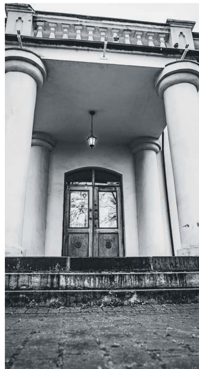
Wejście do budynku od strony północnej
