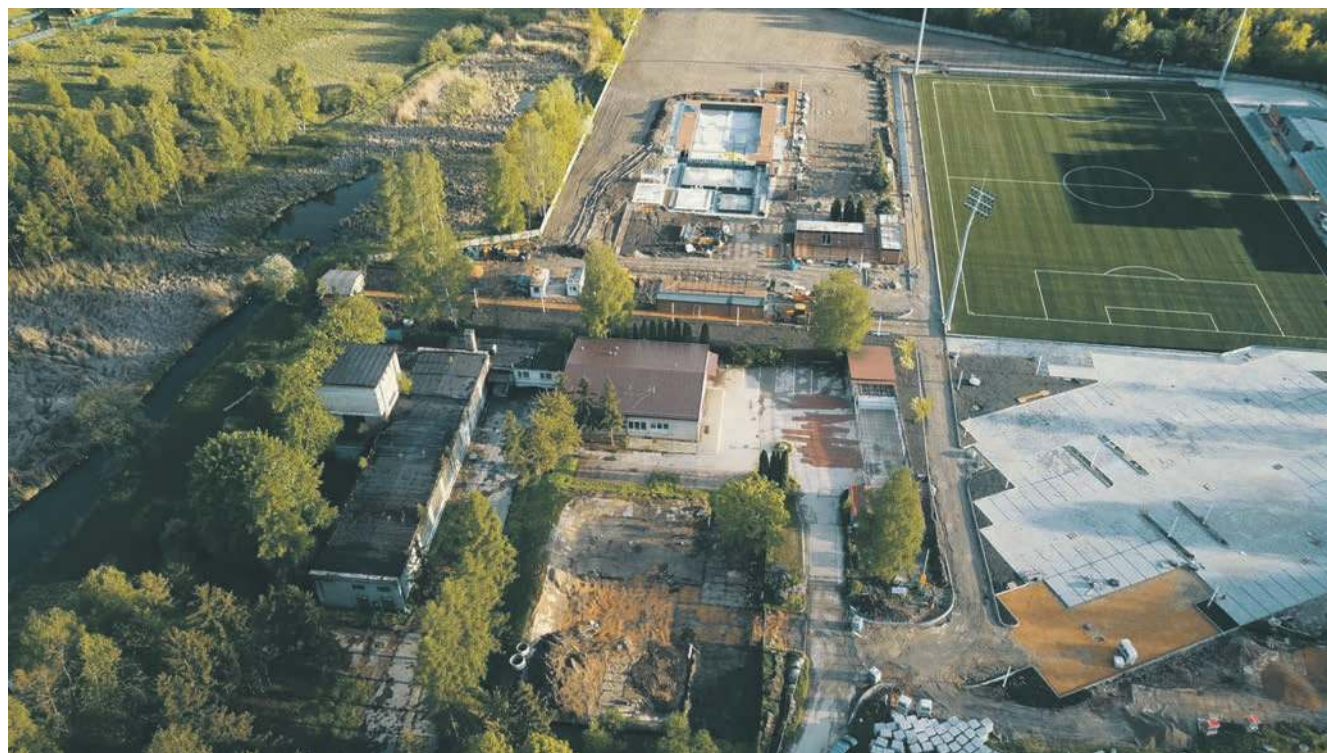
Dawna baza wodociągów w sąsiedztwie modernizowanego ośrodka sportowo-rekreacyjnego na chrzanowskich Kątach. Zdjęcie dronem wykonał Mateusz Rękawek z facebookowej grupy PRZEŁOMowe Kadry
