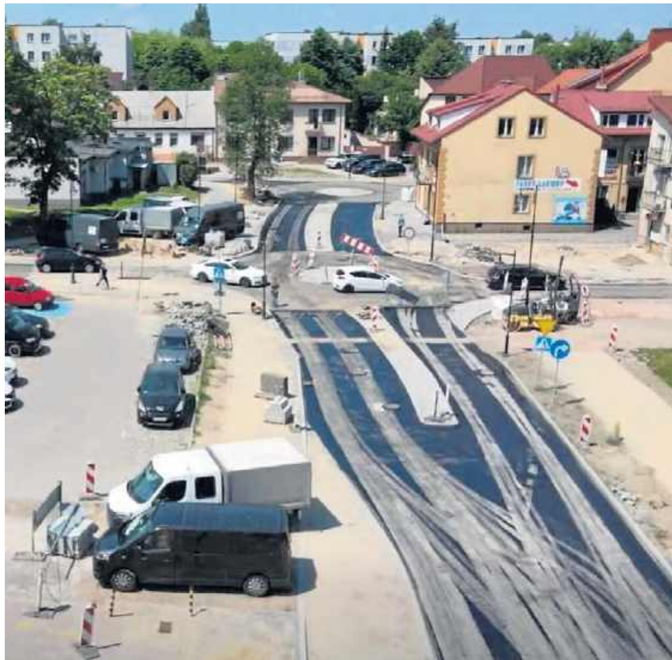
Przez ostatnie dni na remontowanych ulicach układana była warstwa ścieralna asfaltu.
