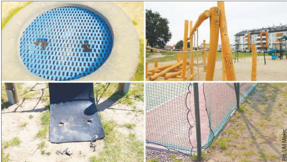
W ostatnich tygodniach zdewastowane zostało także boisko i plac zabaw przy ulicy Staffa oraz plac zabaw przy Rzecznej i siłownia zewnętrzna przy Tańskiego.
