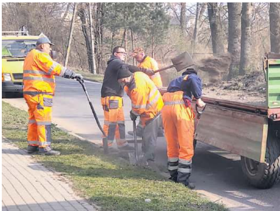
Prace porządkowe na ul. Biskupickiej w Wiązowie
