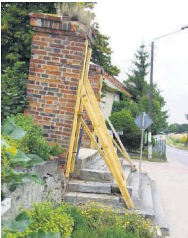
Przechylone i podparte żerdziami ceglane słupy tak się prezentują w centrum Starego Wiązowa nieprzerwanie od 2018 roku (wtedy zrobione zostało to zdjęcie). Aby to się zmieniło, potrzebne są pieniądze
