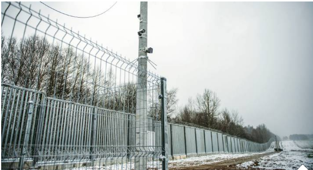
Kończy się budowa zapory elektronicznej na granicy polsko-białoruskiej, czyli systemu kamer i czujników. Jest ona uzupełnieniem zbudowanej w ubiegłym roku na 186 km granicy zapory stalowej o wysokości 5,5 m | fot. Attila Husejnow/Forum
