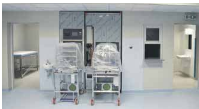
Trwają prace wykończeniowe
