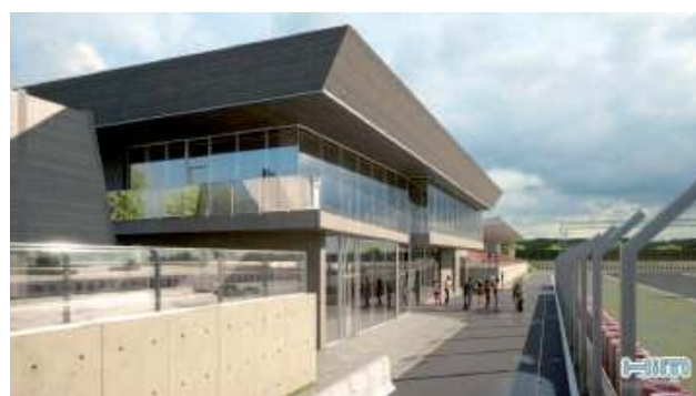
Wybudowany zostanie nowoczesny budynek obsługujący cały Autodrom zarówno podczas zawodów, ale także poza nimi
