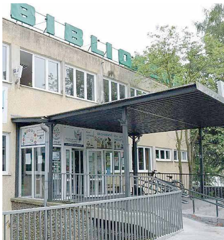
Aby móc rozpocząć przebudowę Miejskiej Biblioteki Publicznej trzeba będzie pozyskać środki zewnętrzne
