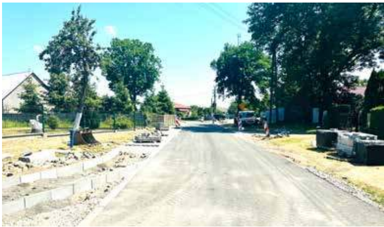
Roboty drogowe w miejscowości Łęczycy idą zgodnie z planem. Na początku przyszłego roku mieszkańcy będą korzystali z nowej drogi
