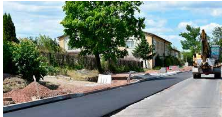
Na ulicy Lotników częściowo widać zupełnie nową nawierzchnię bitumiczną
