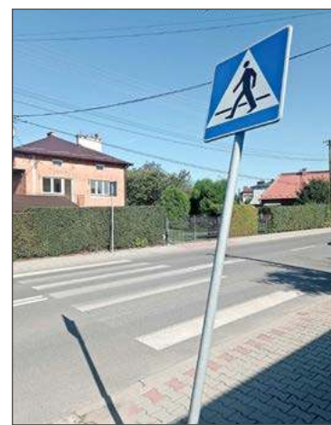
To przejście jeszcze poczeka na odnowienie.
