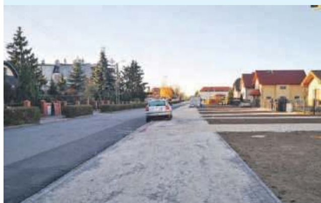
Chodnik oraz kanalizacja deszczowa na ul. Nowoosadniczej
