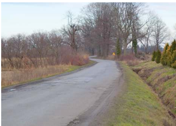
Droga relacji Prusy – Gołostowice zostanie przebudowana
