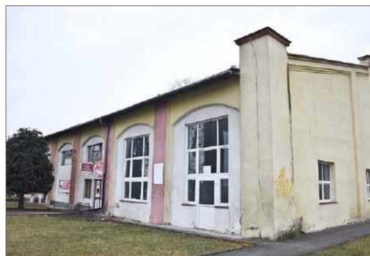
Hal przy ul. Kościuszki będzie remontowana.
