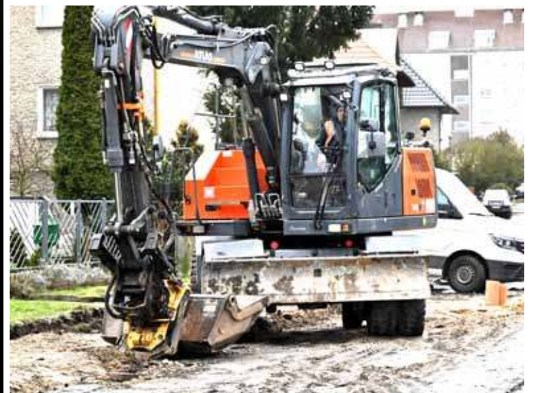
Trwają obecnie prace przy rozbiórce starych chodników
