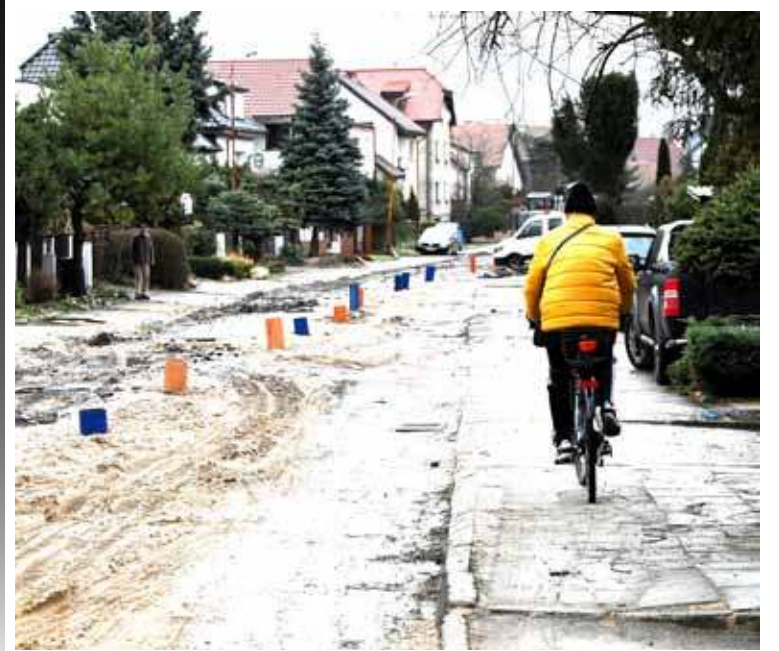
Jak dowiadujemy się z informacji urzędu, na ul. Warzywnej przebudowany już został cały wodociąg.
