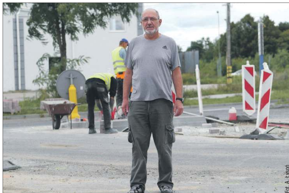
Krzysztof Mojek czuje się pokrzywdzony w wyniku prowadzonego remontu ulicy Przemysłowej w Mielcu.
