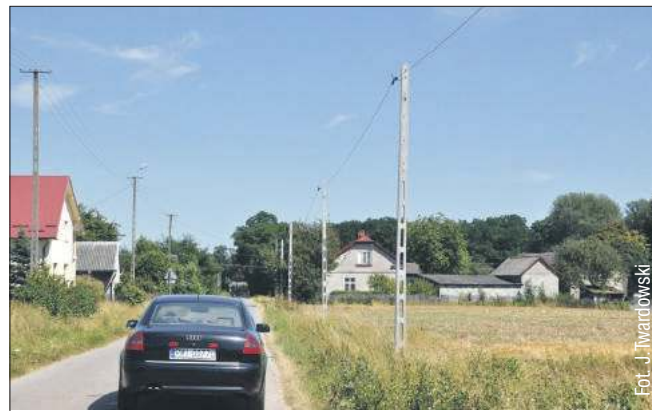
W gminie Borowa każdy, kto zechce, będzie miał Internet. Na zdjęciu budowa sieci światłowodowej na słupach w miejscowości Gliny Wielkie.
