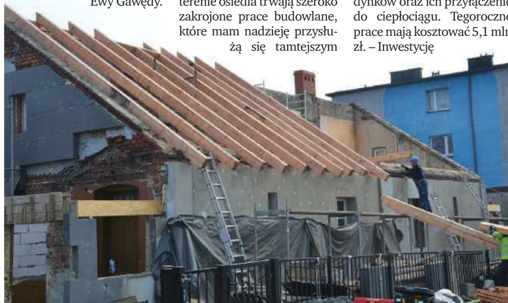
Pracownicy korzystając z dobrej pogody wymieniają również konstrukcje dachów i pokrycia dachowe
