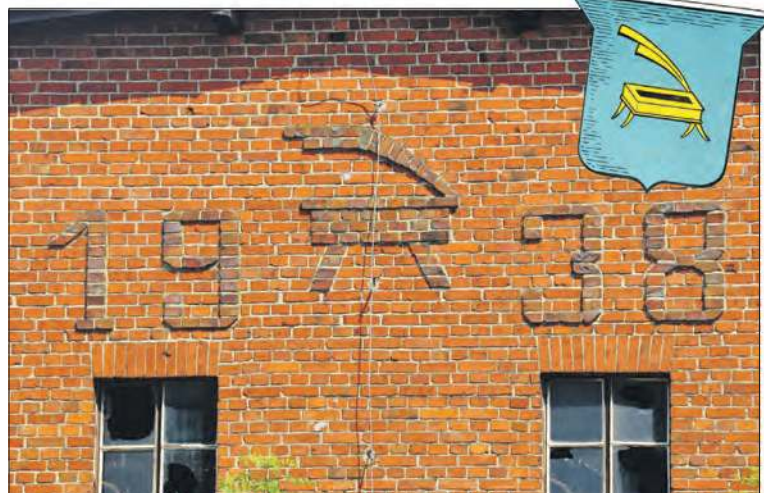
Znak rodziny Habłów uwieczniony na elewacji cegielni przy ul. Soboty
