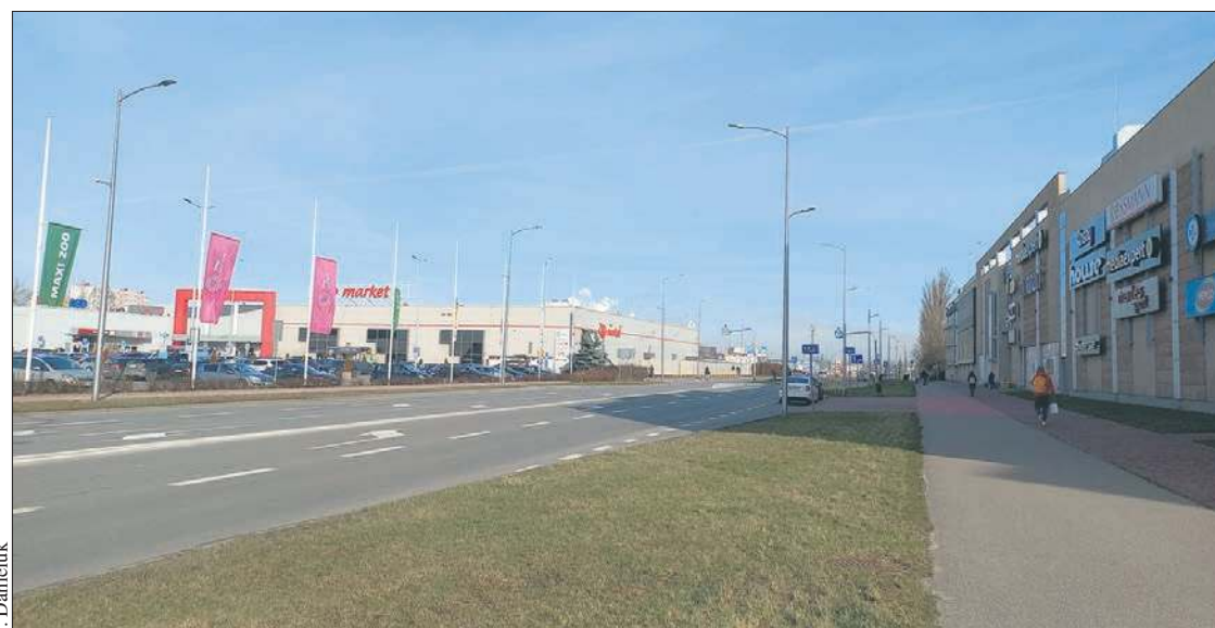
Część ul. Przemysłowej wymaga remontu. Miasto pozyskało na ten cel rządowe dofinansowanie
