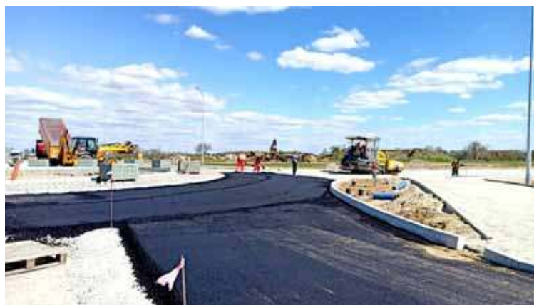
Na przedłużanej części ul. Metalowej kładziona jest nawierzchnia bitumiczna
