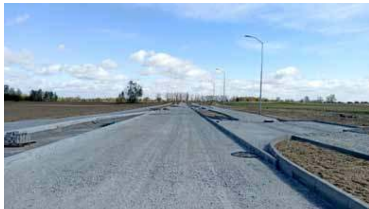
Wzdłuż nowej jezdni powstanie chodnik z kostki betonowej
