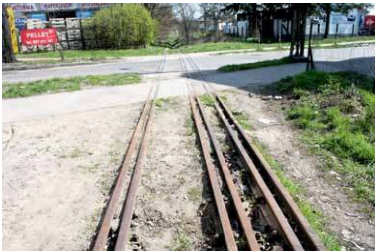
Ruch na ostatnim działającym odcinku wąskotorówki relacji Stargard - Dobra Nowogardzka zawieszono w 2001 r. Mija więc co najmniej 20 lat od kiedy te szyny czekały na reaktywację
