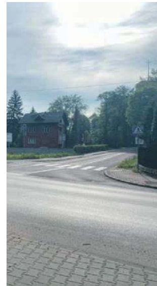
Skrzyżowanie ulic Kościelnej i Piłsudskiego uchodzi za jedno z niebezpieczniejszych w gminie Trzebinia
