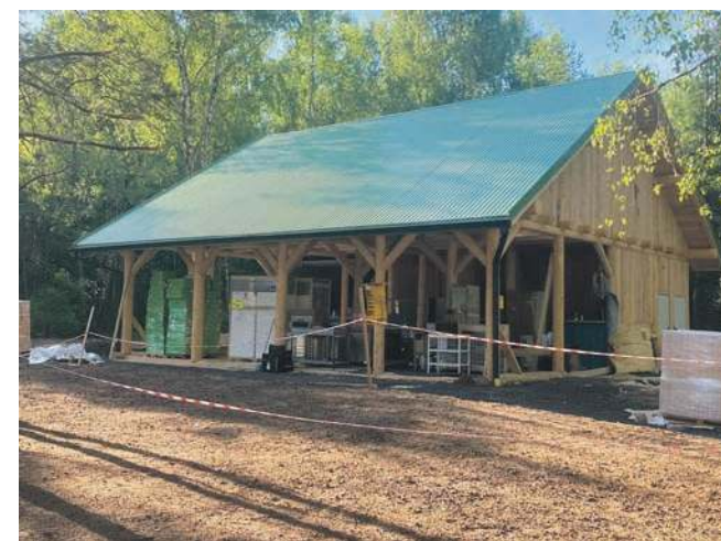
Tak wygląda budynek przyszłej restauracji nad Balatonem
