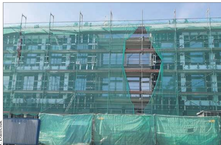
Trwa odbudowa kamienicy przy ul. Królewieckiej 18
