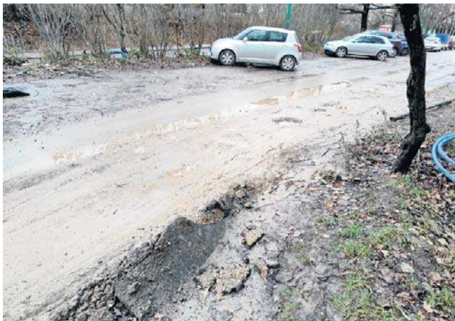
Wg naszego Czytelnika, ul. Montażowa w okolicy skrzyżowania z ul. Motorową jest w opłakanym stanie
