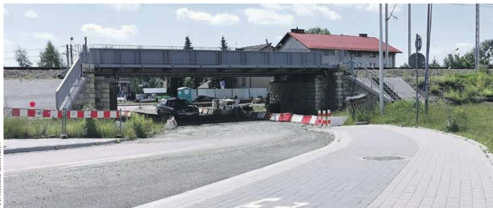
Wiadukt kolejowy nad ul. 29 Listopada w Chrzanowie
