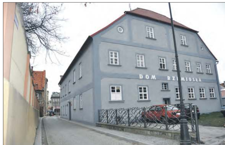
Rzutem na taśmę przed wybuchem wojny niemiecki konserwator zabytków przeprowadził wykonany z pietyzmem remont Domu Cechu Tkaczy w Prudniku. Dzięki temu budynek był w znakomitym stanie, gdy przejmowała go polska administracja i taki też stopień zadbania utrzymuje się również dziś.
