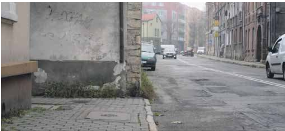
Podczas remontu ul. Powstańców Śląskich zostanie wyburzony budynek, który graniczy z jezdnią
